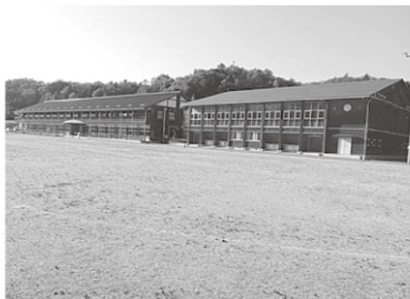
亀嵩小学校に仮設教室棟を併設させ 仮の統合小学校に
